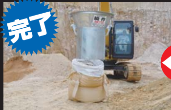
④「瞬作」を抜いて作業完了
