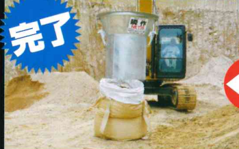
④「瞬作」を抜いて作業完了
