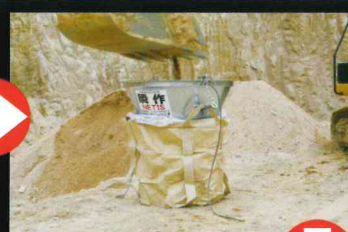
②バケツで「瞬作」に土砂を入れる
